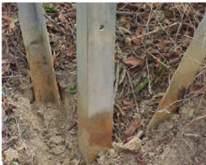
Corrosión en la pata de la torre.
