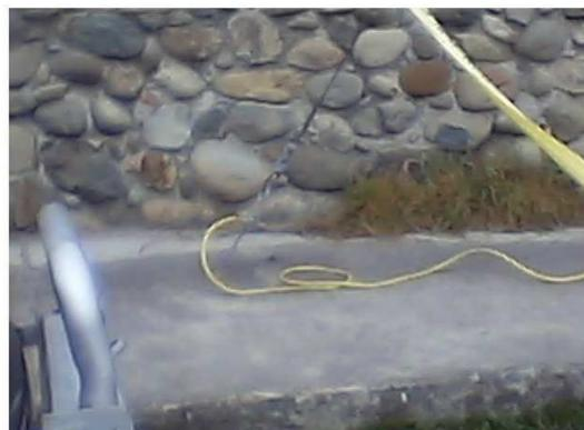
**Fig. 8. Uso de un tensor como sistema de puesta a tierra.**
