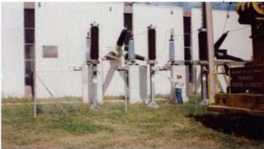
**Fig. 10. Lavado con elementos energizados en una subestación. Incumplimientos de medidas de seguridad: no uso de tierra de seguridad ni de plataforma aislante para ejecutar el lavado.**
