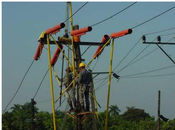
**Fig. 7. Incumplimiento de medidas de seguridad. No uso de mangas aislantes.**
