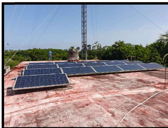
Fig. 2. Sistema Fotovoltaico instalado en la cubierta del CT Minas
